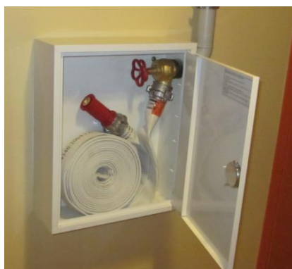
(Tuletõrje voolikusüsteemi kapp)
